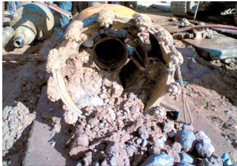
Mit Steinen gefüllter Räumernach dem Ausbau.
